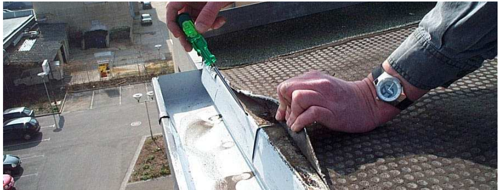
Säure-Lochfraß bei Zink durch FPO-Bahn (Rowalin)
