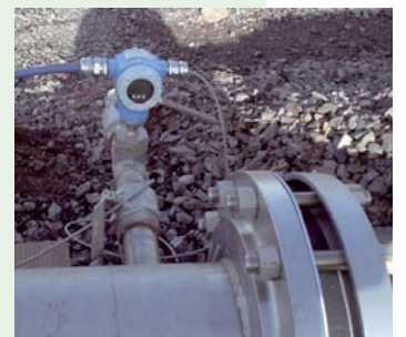
Promag (oben) und Cerabar behalten die Chemikalienzufuhr im Blick
