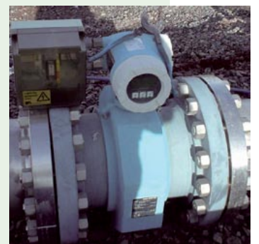
Promag (oben) und Cerabar behalten die Chemikalienzufuhr im Blick
