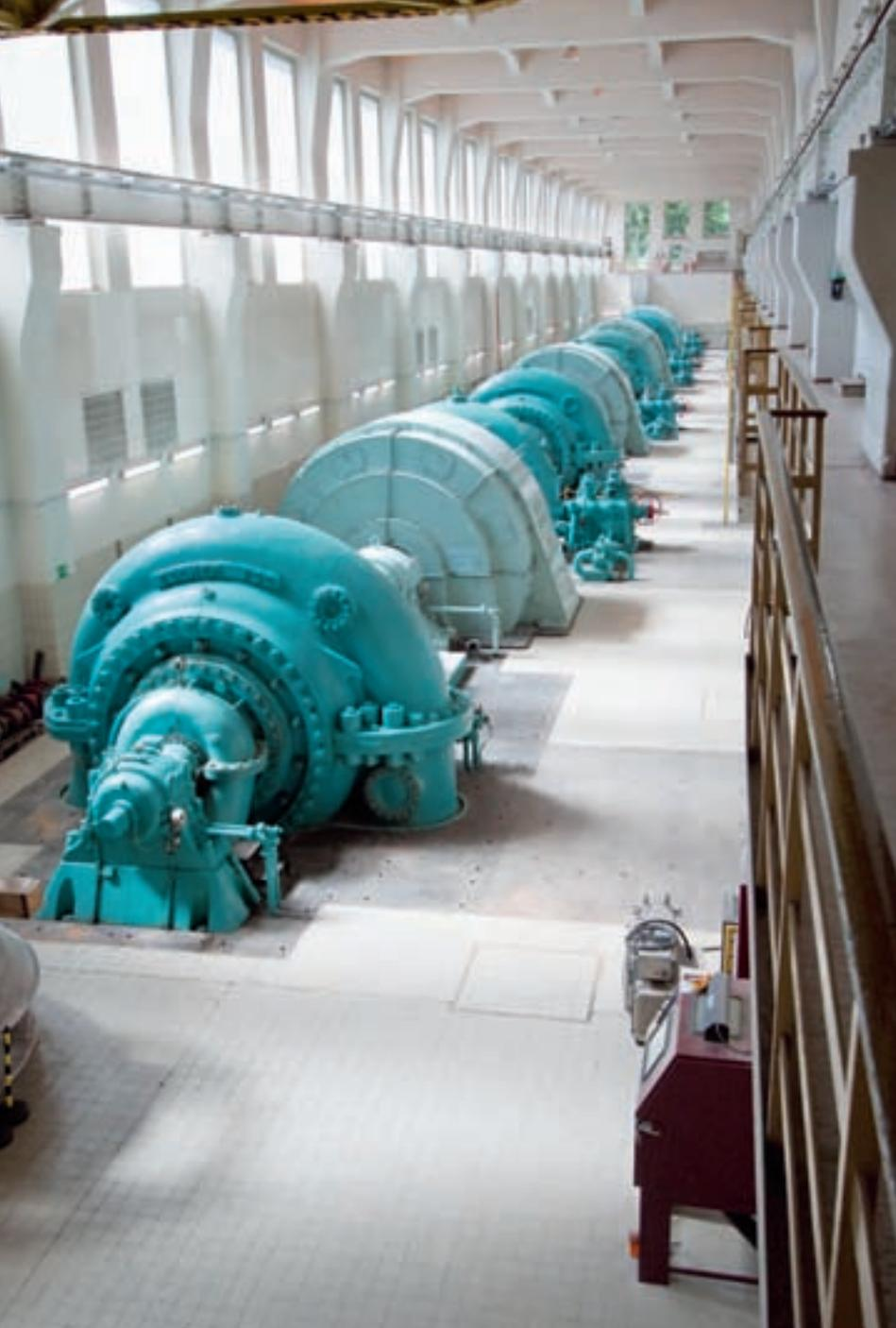
**Alteisen:** In der Turbinenhalle von Waldeck I sind nur noch zwei Aggregate mit jeweils 35 MW in Betrieb. Seit diesem Jahr leistet ein neu gebautes Schachtkraftwerk zusätzlich 70 MW.
